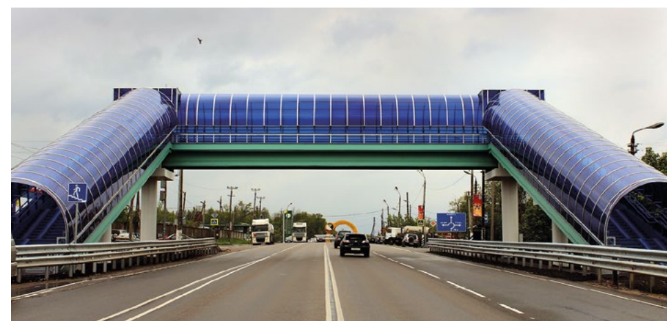
Новый пешеходный переход в н.п. Иншинский Ленинского района Тульской области автомобильной дороги 1Р-132 Калуга – Тула – Михайлов – Рязань км 96+040
