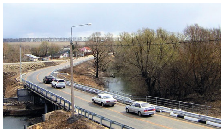
Движение транзитного транспорта по временному мосту через р. Неполодь автомобильной дороги Р-92 Калуга – Перемышль – Белев – Орел, км 196 в Орловской области. Основной мост закрыт на реконструкцию
