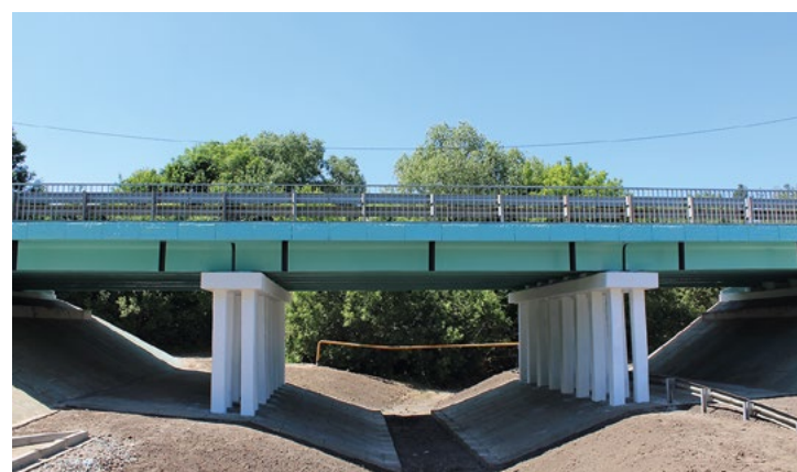
Отремонтированный мост через суходол, км 204 автомобильной дороги Р-92 Калуга – Перемышль – Белев – Орел в Орловской области
